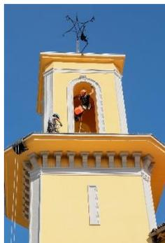
Pour finir, le traitement anti-volatile comprenait la pose de pics sur les corniches et l'installation de grilles d'herméticité sur les fenêtres de la montée des escaliers. Celles-ci ont été directement posées par le cordiste – chaudronnier d'A.T.X.
